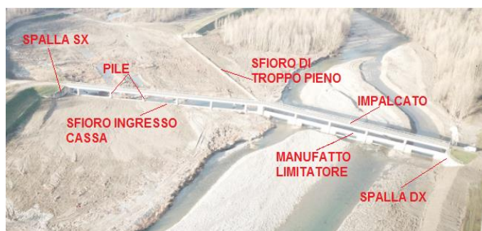
Fig.9.3 - Manufatto limitatore di monte con impalcato.
