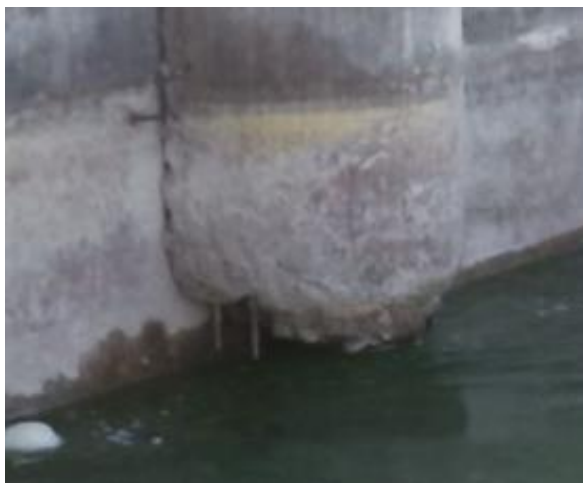
Fig.9.4 - Degrado alla base delle pile
