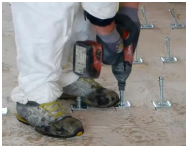
Fig.8.4 – Applicazione connettori meccanici.
