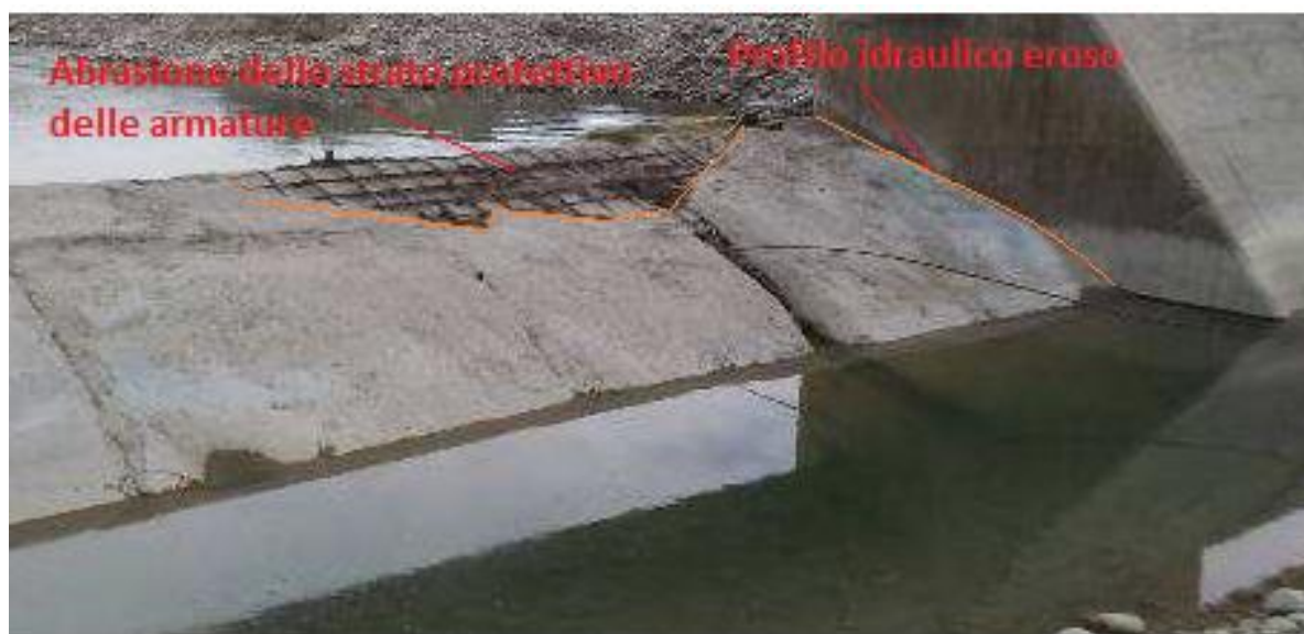
Fig.7.1 – Abrasione in Alveo
